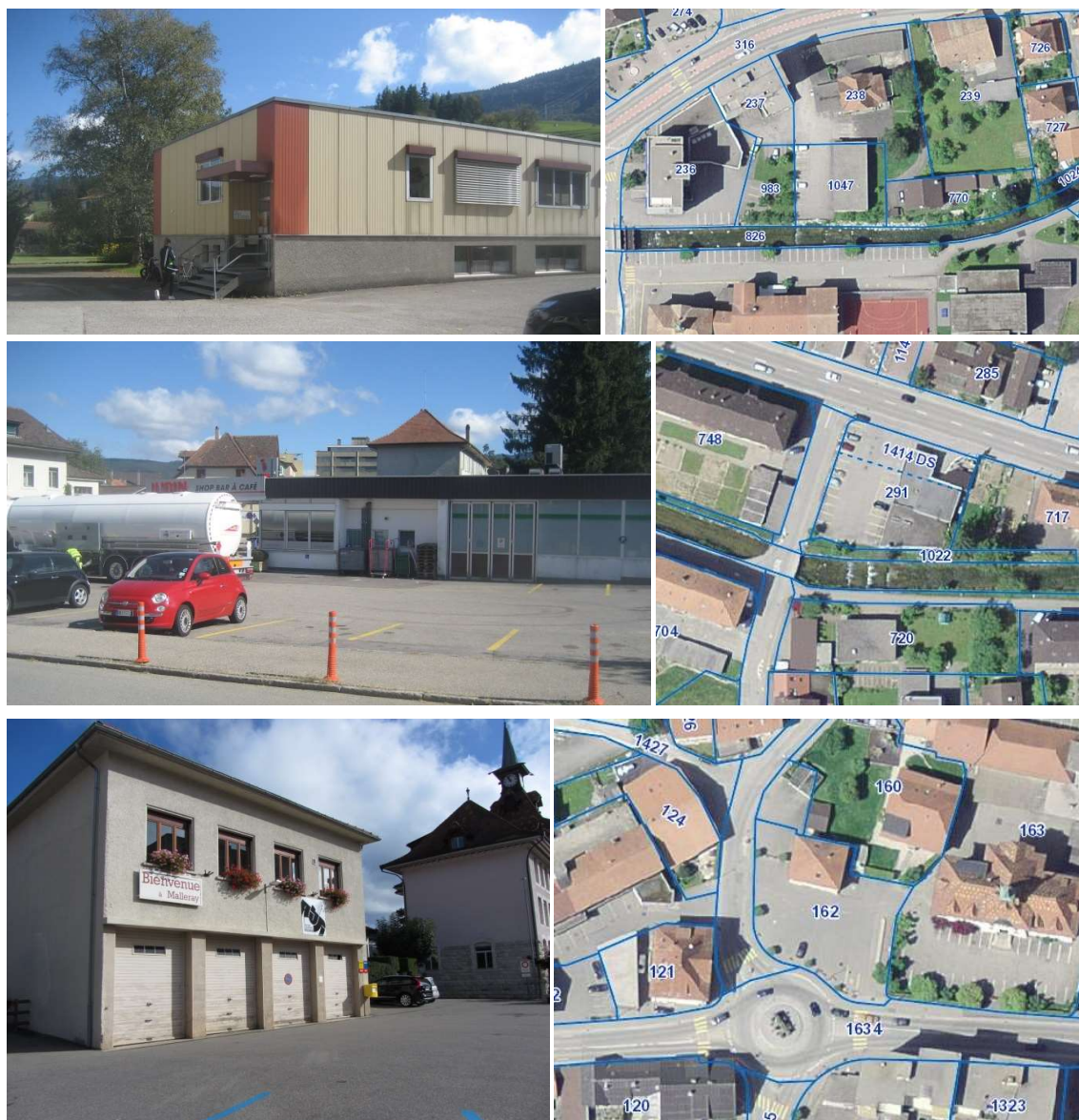
iii. III.1 – III.6 : Compte tenu de leur environnement respectif, les bf 1047, 291 ( Bévilard ) et 162 ( Malleray ) figurent parmi les quelques bâtiments à même de pouvoir, à terme, être déconstruits pour pouvoir offrir de meilleures constructibilités
